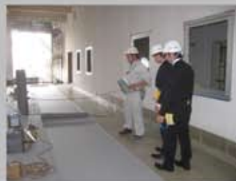
【市内工場増築現場】
