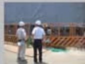
【市内工場増築現場】
